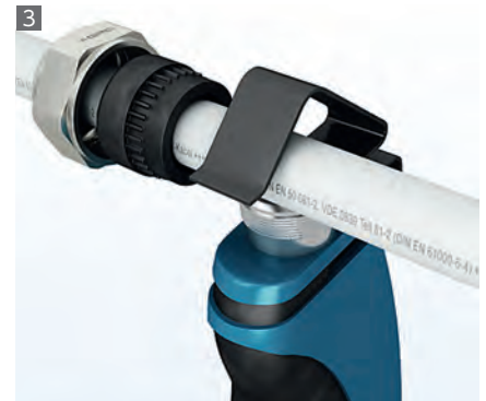
3 シールドケーブルの被覆を剥く。
